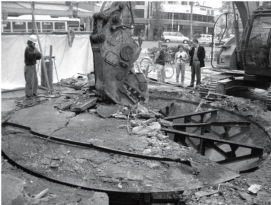
解体直前 転車台の全貌が現れました。
